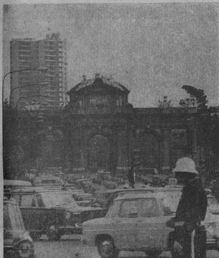
Madrid.—Detrás de la "Puerta de Alcalá" aparece la polémica "Torre de Valencia". El ministro de la Vivienda, haciendo uso de las facultades que le concede la vigente legislación, ha decidido suspender la realización que aprobó la transformación de este solar. Ahora toca esperar el resultado final.—(Foto Europa Press).
