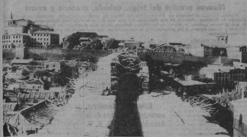
He aquí, en esta fotografía, la posición en que se encuentra montada, sobre la parte superior del acueducto, la tubería de hierro que hasta hace poco tiempo era utilizada para conducir el agua potable a un sector de la capital. Dicha tubería, como se
