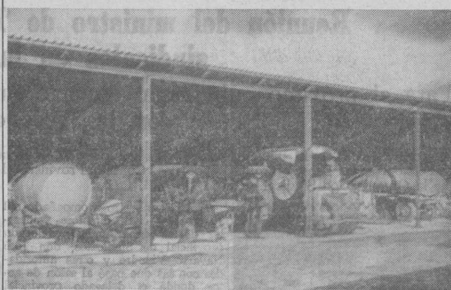
Detalle de uno de los cobertizos para guardar maquinaria en la finca de Quitapesares.—(Foto Antonio)
