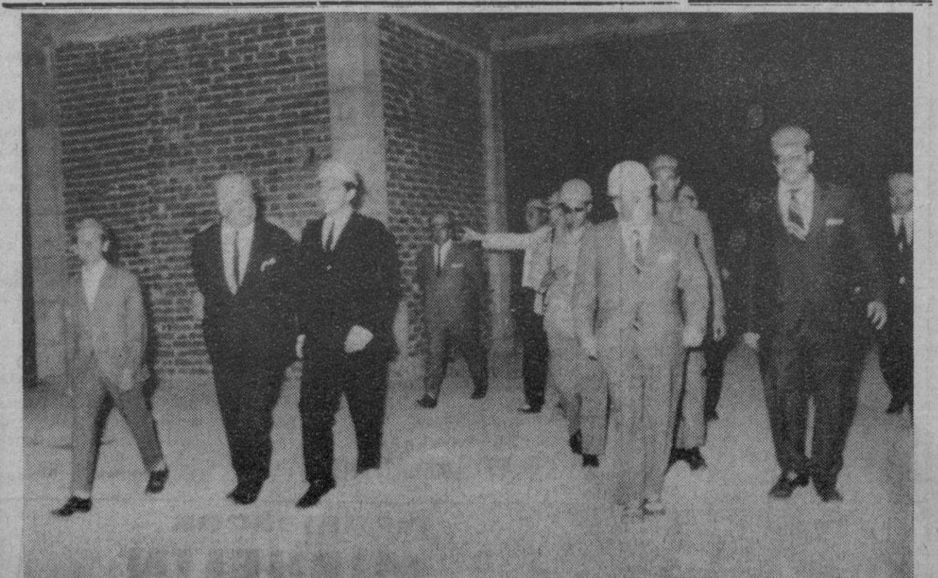
El gobernador civil, acompañado del alcalde, técnicos, constructores y concejales, durante su visita a las obras de construcción de la estación de autobuses.—(Foto Félix París)
