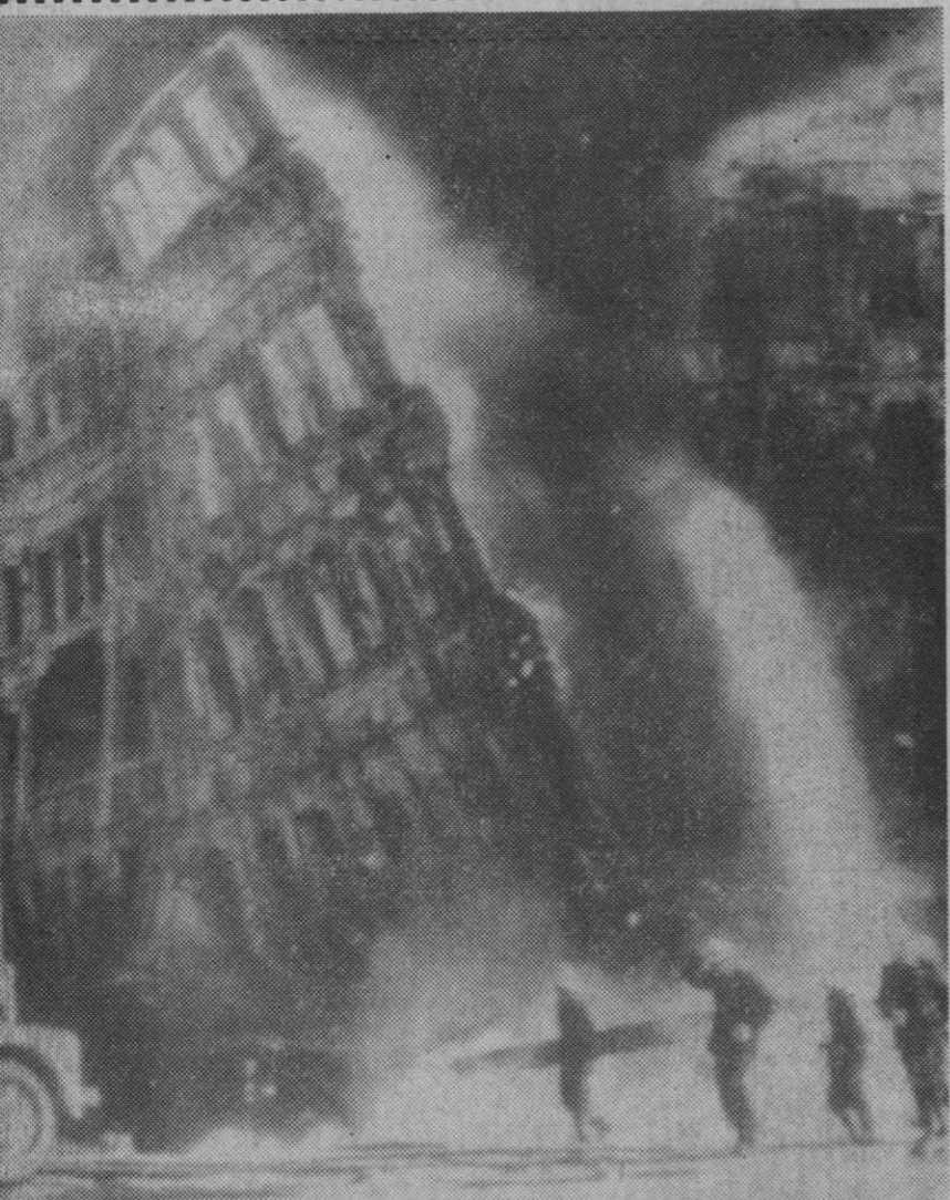
Sydney (Australia).—Los bomberos luchan contra el incendio de un edificio de cinco pisos, que a causa del fuego se derrumbó. Afortunadamente, no se registró ni un solo herido.—(Telefoto AP-Europa Press)
