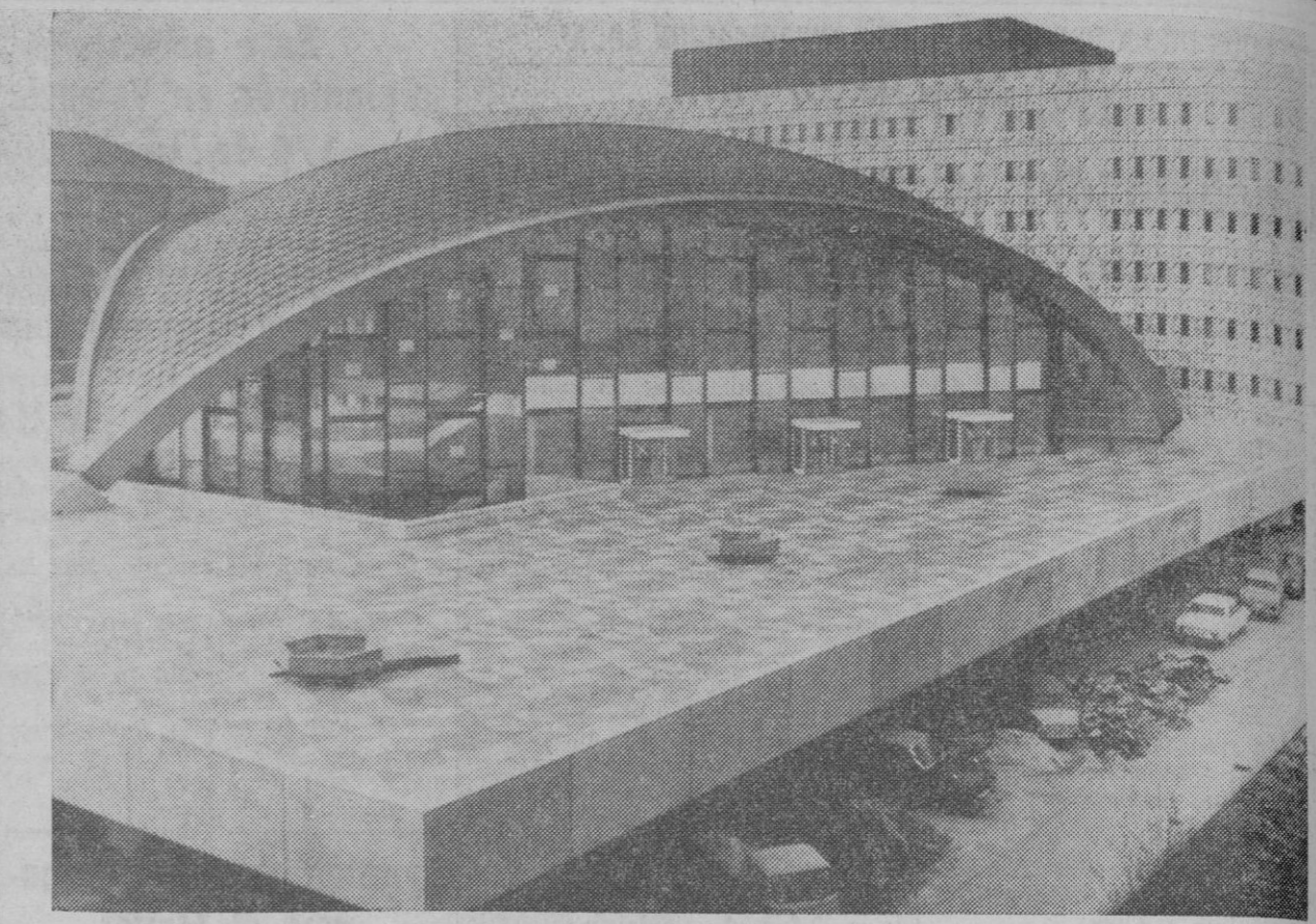
Uno de los teatros más modernos del mundo, será el inaugurado el 3 de marzo próximo en la ciudad industrial de Dortmund en la Alemania occidental. Atracción arquitectónica es la cúpula libremente suspendida, de una extensión de cincuenta y cuatro metros, que inspiró a los habitantes de Dortmund a darla el sobrenombre de "cáscara de huevo". El espesor de hormigón, de sólo ochenta y cinco milímetros, del techo de cúpula, que descansa sobre tres pies, es más delgado en proporción que la frágil envoltura de cal de un huevo de gallina. Hasta ahora no hay ninguna construcción tan atrevida de dimensiones comparables. El edificio transversal (en el fondo del escenario) contiene el escenario, los talleres y las oficinas de la administración. Los espectadores que vienen en su propio coche pueden estacionar éste en el garaje subterráneo, utilizando allí un ascensor para llegar directamente al foyer. Como estreno de gala será representado el 3 de marzo ante los primeros mil doscientos espectadores el "El Caballero de la Rosa" de Ricardo Strauss.
