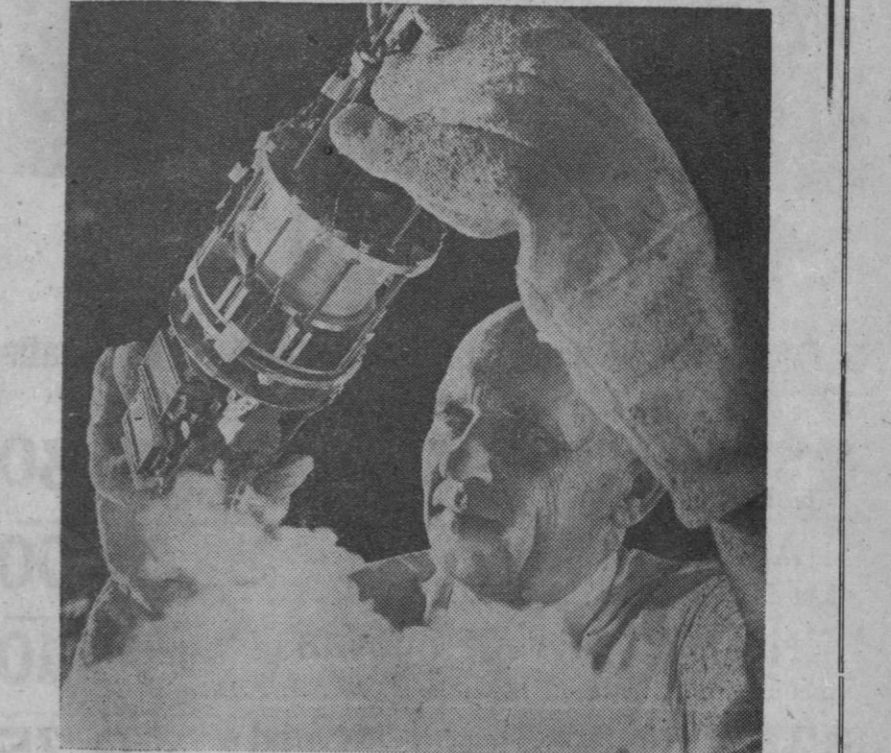
La bomba transforma una pequeña cantidad de fluido de corriente alterna en una gran cantidad de potencia generada de corriente continua a temperaturas próximas al cero absoluto. Está destinada a generar igual cantidad de corriente que una fuente de energía eléctrica convencional del tamaño de una mesa de despacho. El dispositivo en miniatura será utilizado como fuente de corriente de alta tensión para electroimanes que funcionan en ambientes de baja temperatura
