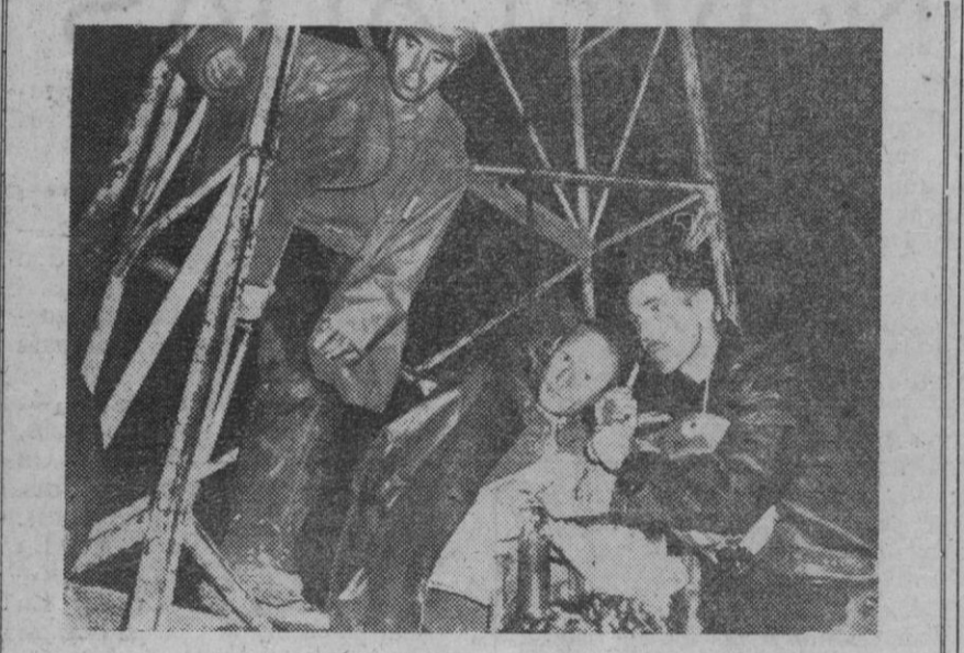
Champagnole (Francia).—Los mineros sepultados en la mina de Champagnole respondieron, como es sabido, a las llamadas que se les había hecho desde el exterior. La primera comunicación con los catorce obreros ha sido establecida por el ingeniero de la mina, M. Minardi. Con este motivo, los equipos de salvamento se esfuerzan por alcanzar a los sepultados. En la foto, el ingeniero Minardi escucha las respuestas de los mineros atrapados en el interior de la mina.—(Foto Europa Press)
