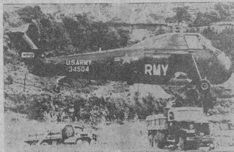
Ante la importante avería causada en la conducción de aguas a Bilbao, ha habido que recurrir a la ayuda de helicópteros norteamericanos de la base europea en Alemania de Mannheim, que junto con otro español colaboran en la reparación de la tubería de agua rota el pasado día 10 por un desprendimiento de tierras, lo que ha reducido el suministro de la ciudad desde mil trescientos litros por segundo a trescientos durante sólo cinco horas al día. En la foto, uno de los helicópteros USA, en pleno trabajo. (Foto Europa Press.)
