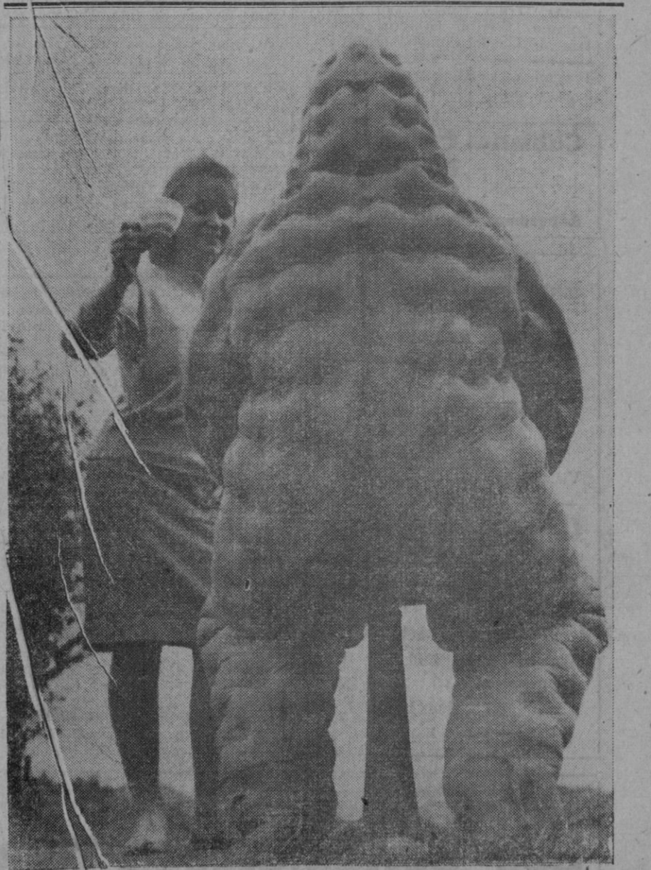
Esto que parece un monstruo tomándose una taza de té, es, en realidad, Stuart Sullivan, quien acababa de probar un traje salvavidas para aviadores que se vean obligados a lanzarse en paracaídas sobre el mar. El traje está confeccionado de una tela de algodón encauchutado especial que forma dos capas; el aire contenido entre ellas aísla contra el frío del agua al aviador y le proporciona flotabilidad. El aviador mismo puede inflar el traje. Otros tipos, destinados a submarinistas que tienen que abandonar el buque debajo del agua, se inflan automáticamente.
