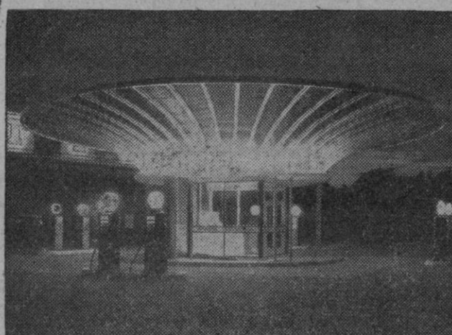
Una interesante muestra de modernos empleos del aluminio en un inusitado diseño arquitectónico, es la que se ofrece en la marquesina del patio frontero de un centro surtidor de gasolina. Tal marquesina se halla configurada en forma de cono invertido, y mide un diámetro exterior de 15,24 m. y uno interior de 6,70 m. En el supuesto de acumulación de peso desequilibrado sobre la misma, tal como la que puede causar una nevada, las 52 varillas de aluminio, que hacen de arcos, reducen la tensión determinada por tal peso, al transformarse en ménsulas de sustentación. El techado es de aluminio laminado. Por debajo de la marquesina se halla el kiosko del encargado del surtidor
