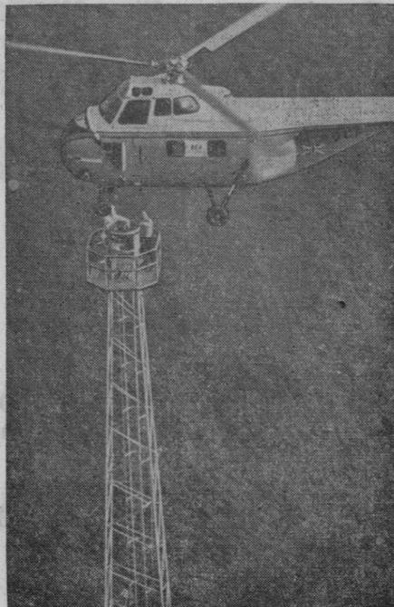
Hace poco tiempo se instaló sobre una torre de 25,5 metros, mediante un helicóptero, y sin emplear ninguna grúa, una baliza de aproximación que pesa media tonelada. La baliza se erigió en un terreno cubierto de arbolado, cerca del nuevo aeropuerto de Gatwick, al sur de Londres, inaugurado el 9 de Junio por Su Majestad la Reina Isabel II.
