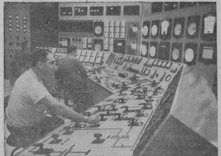
El centro que gobierna la explotación para usos pacíficos de la energía atómica es esta complicada sala de mandos, instalada en la central atómica de Shippingport (Pensilvania). Todas las "instrucciones" al reactor nuclear, a su instalación complementaria y al turbo-generador, las dan esos tres operadores que se ven sentados ante los cuadros de mando. En el primer plano de la fotografía están los mandos del sistema de distribución de energía; en la sección central los del turbo-generador; y, al fondo, los del reactor nuclear. La central atómica de Shippingport ha sido desarrollada conjuntamente por la Westinghouse Electric Corporation, la Comisión de Energía Atómica y la Duquesne Light Company de Pittsburg (Pensilvania).
