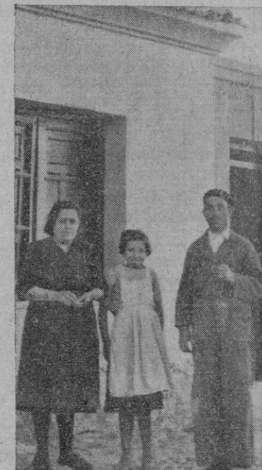
Han terminado. Esta familia, delante de su hogar propio, muestra su gratitud a la Obra Sindical y su legítimo orgullo por el trabajo realizado.
