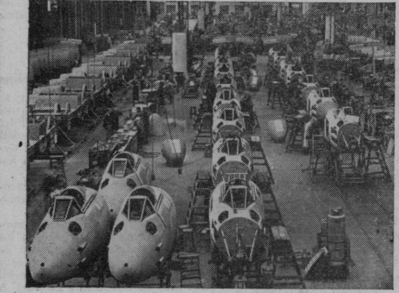
Con la perfección del motor de chorro de gases, por el comodoro del aire británico sir Frank Wittle, se abrieron nuevos horizontes para la Aviación. En esta fotografía podemos ver los "Gloster Meteor IV" en construcción, en los talleres de la Gloucester Aircraft Company
