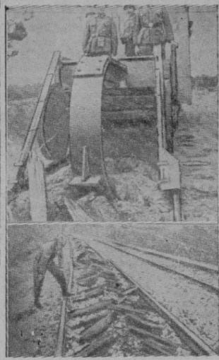
Los alemanes se sirven de una máquina especial para destruir las vías férreas en los territorios que abandonan. La máquina, arrastrada por una potente locomotora, está dotada de fuertes garfios que arrancan y destruyen las traviesas como si se tratase de simples virutas. La foto superior nos presenta a la máquina en actividad en un ferrocarril italiano. Abajo un sargento inglés constata los efectos de la máquina destruyevías.
