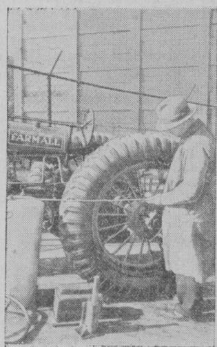
En América ha sido lanzado al mercado un nuevo neumático, en el que el agua sustituye al aire. Parece que el agua templada mejor los golpes, por cuya razón se destina en principio este neumático a tractores y camiones. La ilustración presenta un tractor dotado de dicha clase de neumáticos
