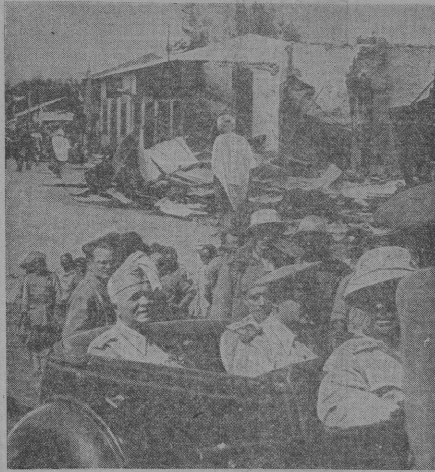
Una vista de Addis Abeba, destruida por el fuego y los saqueos. En primer término, el mariscal Badoglio recorriendo la población poco después de entrar las tropas italianas
