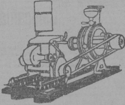
es el motor más conveniente tanto para la agricultura como para la industria; con él se pueden mover una infinidad de máquinas útiles. Elevación de aguas, aserrar-madera, pelar almendras, cortar forrajes, mover norias, producir electricidad para alumbrado y fuerza, mouturación y trituración de granos, etc.
