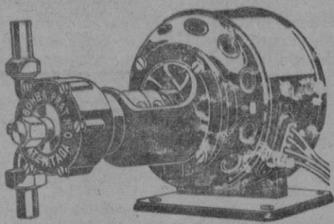
**Ideal** para usos domésticos. 500 litros de agua por hora a 40 metros altura. Acoplada a motores **monofásicos** de 1/4, 1/6 y 1/8 de HP. que puede conectarse a líneas ordinarias de luz. La **Bomba Prat** sirve perfectamente para el trasiego de vinos y aceites. Innumerables referencias en Palma y pueblos de la isla. Grandes existencias de los grupos más corrientes. Pilas y estuches de todas clases. Niquelado, dorado y plateado de toda clase de metales. Se cargan acumuladores.
