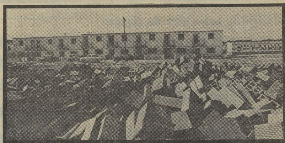
Los ladrillos esperan amontonados la solución del conflicto. Al fondo, las viviendas ya edificadas y la piscina municipal...
