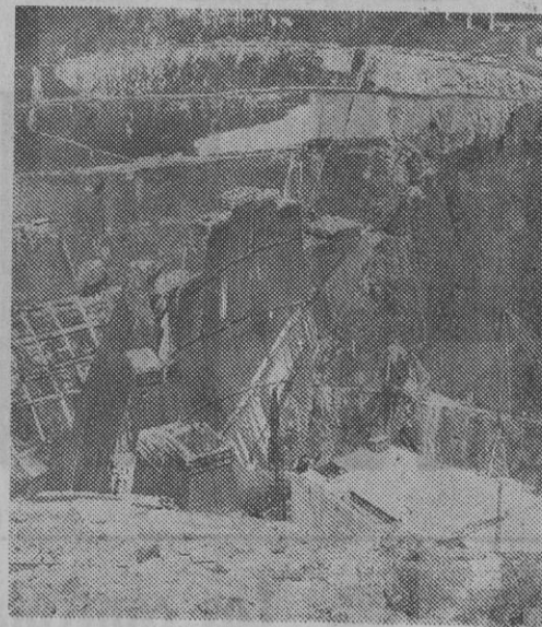
Vista del estado de construcción de la presa del Atazar
