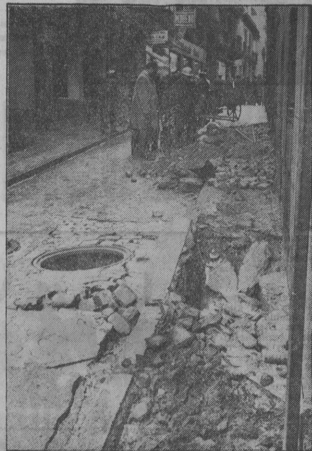
Aspecto de la calle Cañizares, afectada por la explosión de gas.
