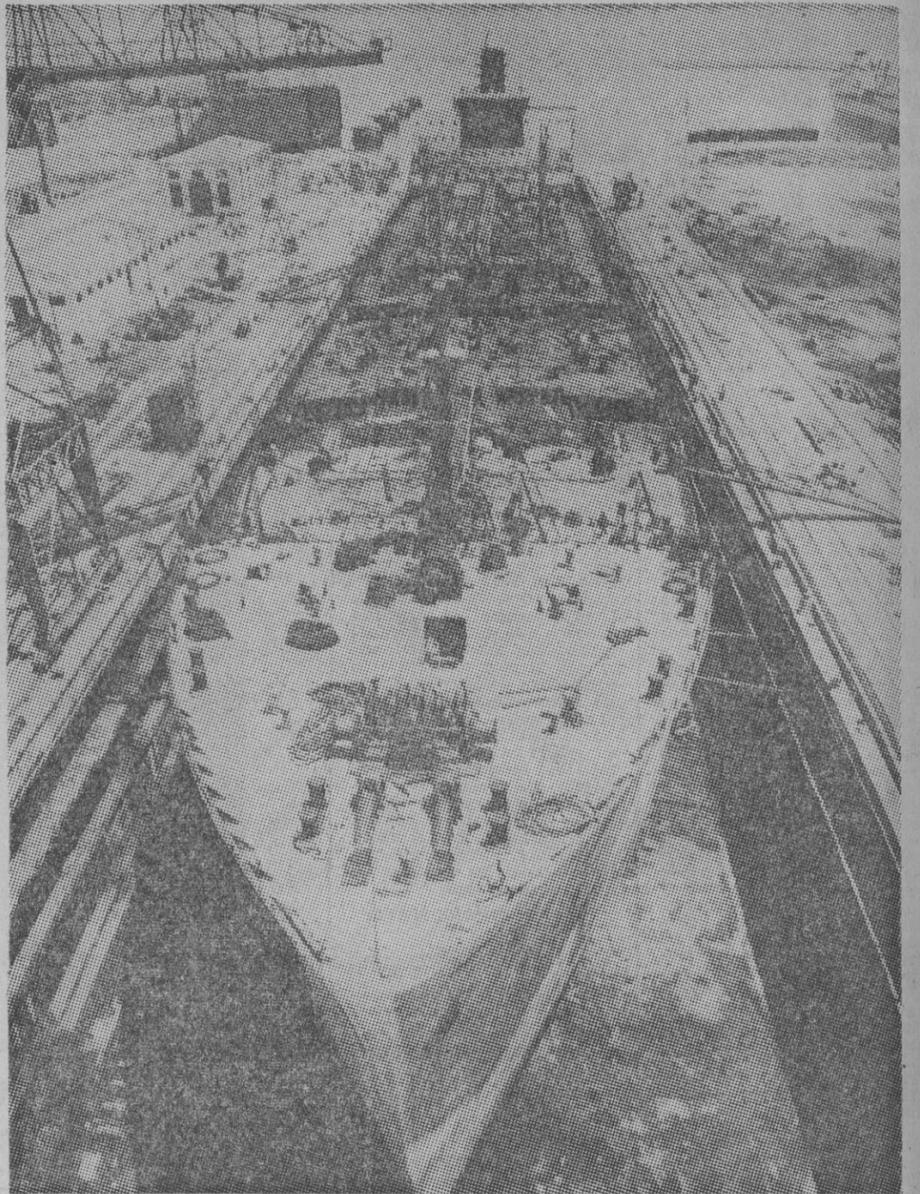
Petrolero inglés «Esso Durham», reparado y transformado en el dique seco. Se le aumentó la eslora en 12,20 metros.
