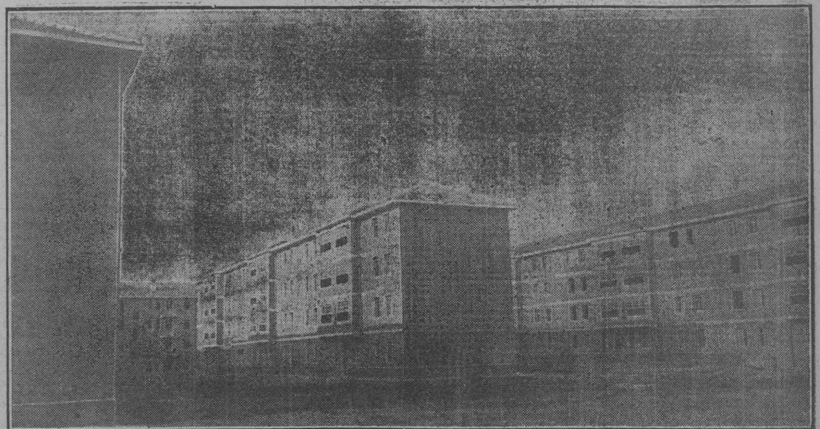
Vista parcial del grupo Sestao, de 152 viviendas.
