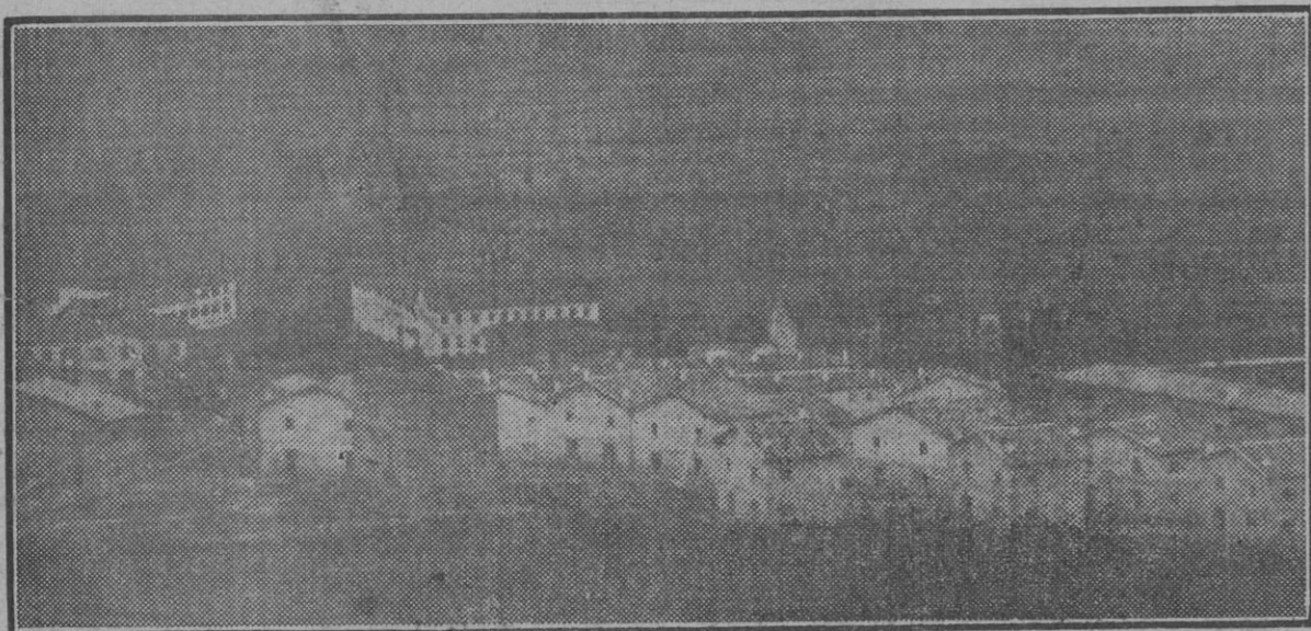
Vista panorámica de un grupo de viviendas en construcción.
