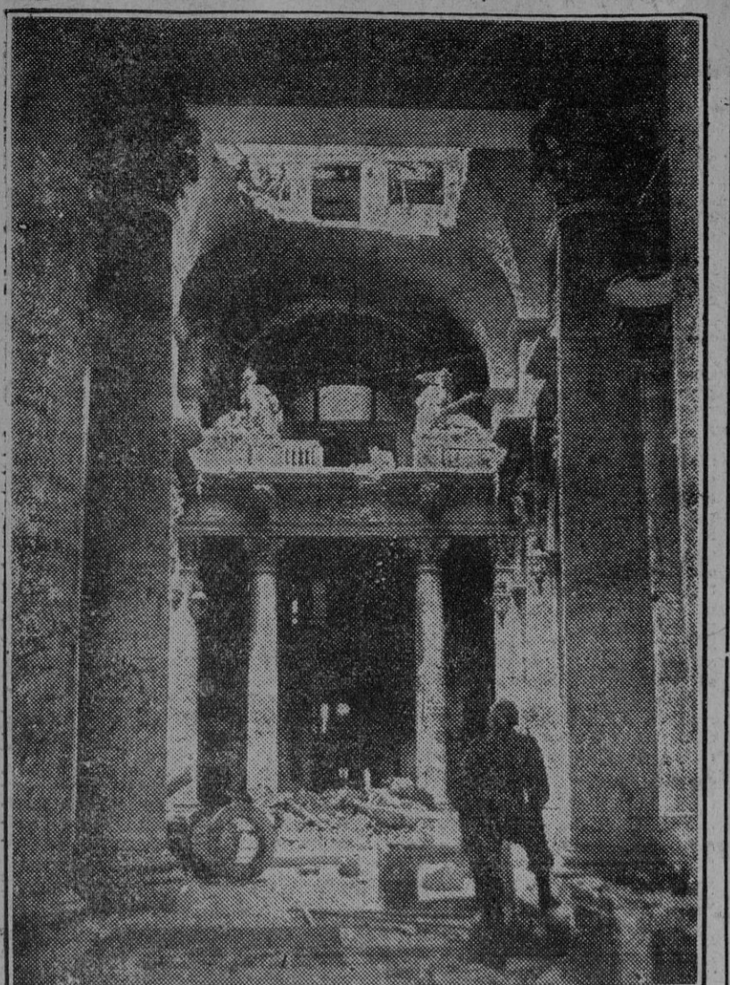
Una vista de la entrada del edificio del Reichstag, donde los soldados rusos realizan trabajos de protección de muros y columnas para evitar un posible derrumbamiento. (Foto G. H. de Espartero).
