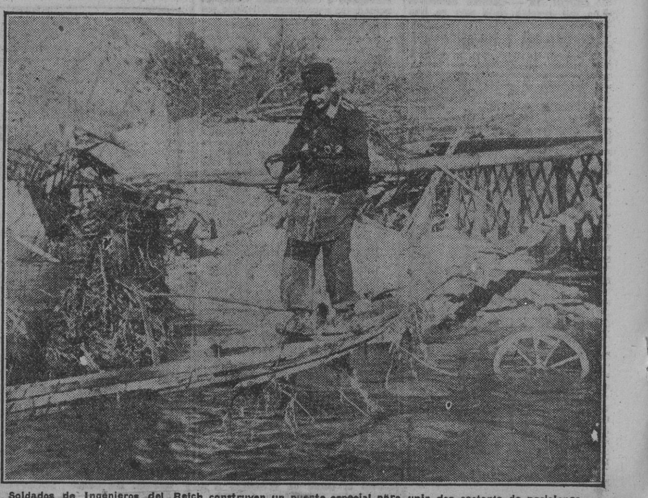
Soldados de Ingenieros del Reich construyen un puente especial para unir dos sectores de posiciones. (Foto Weibbild.)
