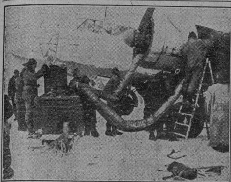
La temperatura glacial de Rusia supone un gran obstáculo para el funcionamiento de los órganos de combustión de los motores congelados vuelven a la normalidad mediante los vapores emitidos por grandes cámaras que contienen agua en ebullición.
