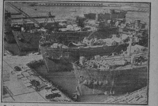
En el puerto de Los Angeles se dan los últimos toques a estos cuatro buques, de 10.000 toneladas cada uno, que serán empalmados para el transporte de víveres y material. La forma especial de la proa y la distribución de pesos determina un desplazamiento del centro de gravedad útil, favorable a la mayor velocidad de la nave.
