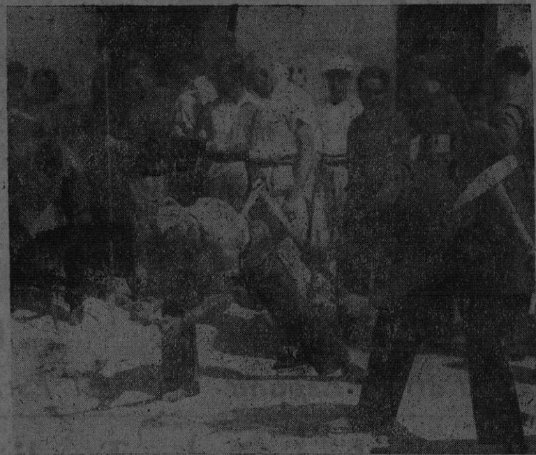
Otro grupo de Empresarios y Obreros de la O.N.S. trabajando en el nuevo refugio.
