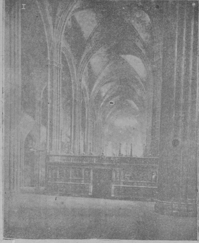
Estado actual de la Catedral con el coro, en la parte central, como estaba en Palma
