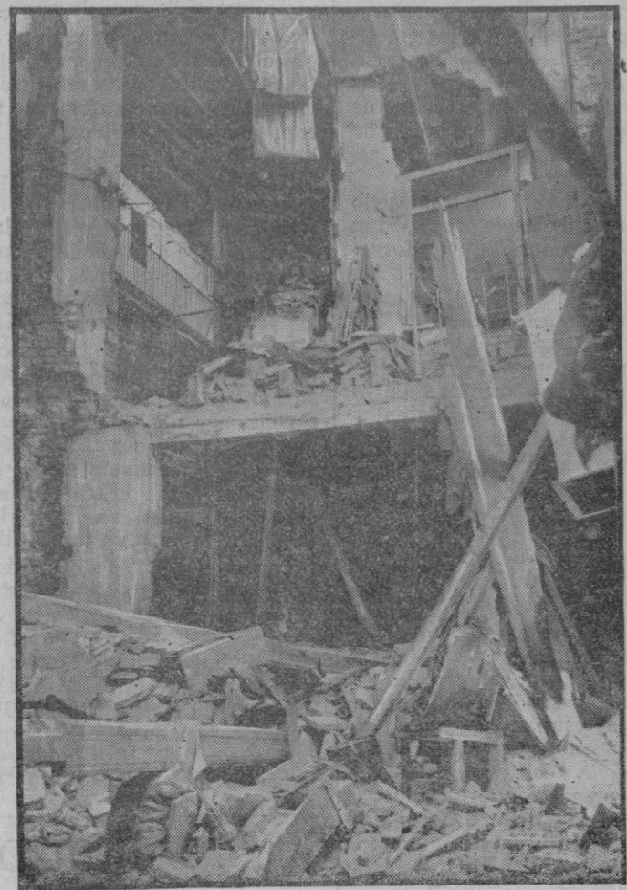
UNA CATASTROFE EN VALENCIA—Explosión de gases benzol. En una tintorería de la calle del Morrall, ha explotado una caldera causando un muerto y más de 20 heridos. Tres pisos de la casa lindante con la tintorería se yinieron abajo. Un aspecto de la catástrofe.
