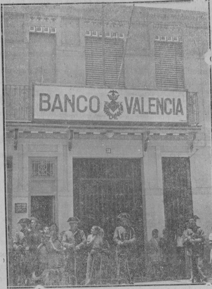
Edificio de la Sucursal del Banco de Valencia en Benetuser (Valencia) en el que se ha cometido un atraco de 40.000 pesetas
