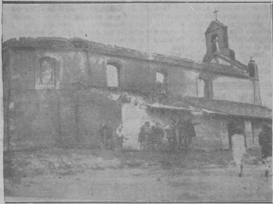
VIZCAYA. — Exterior de la Iglesia de Nuestra Señora de la Asunción, que fué rociada con gasolina y destruída por el fuego
