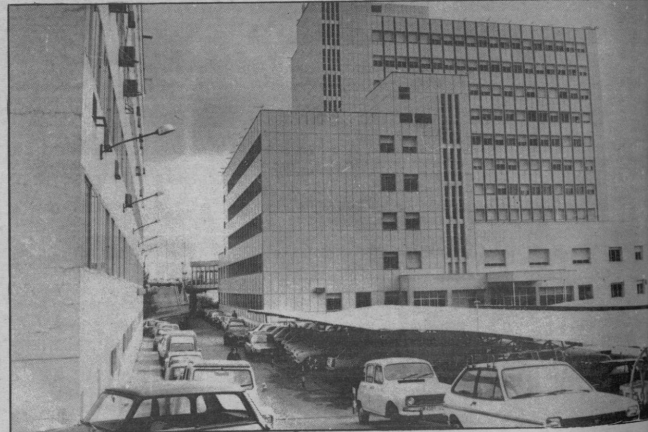
Con las obras que se realizan, una nueva imagen.
