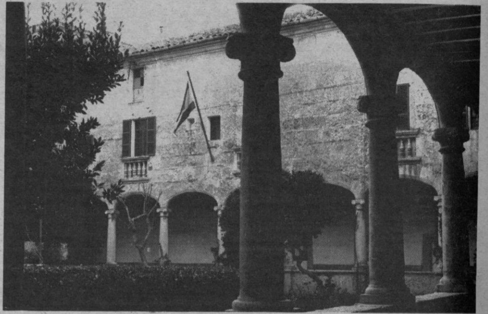
Los arcos rebajados o carpaneles cargan sobre las columnas de capiteles del renacimiento (Foto: Quelglas)
