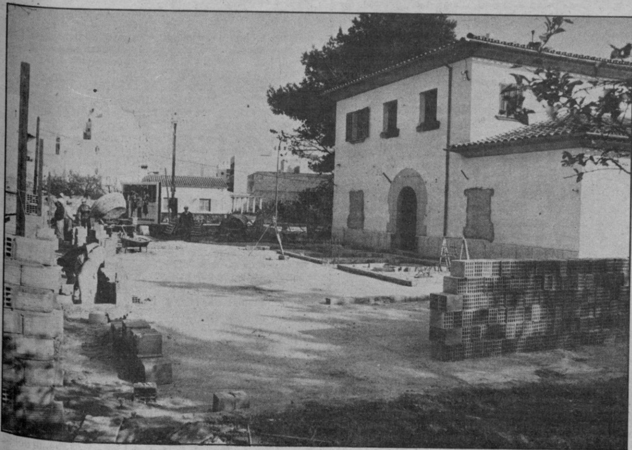
Se han iniciado las obras del nuevo centro emisor de TVE en Baleares. Corren a cargo del C.G.I.
