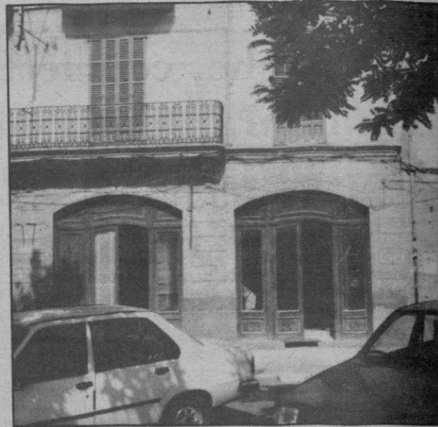
Fachada de lo que será el nuevo cuartelillo de la Policía Municipal (Foto Clar)
