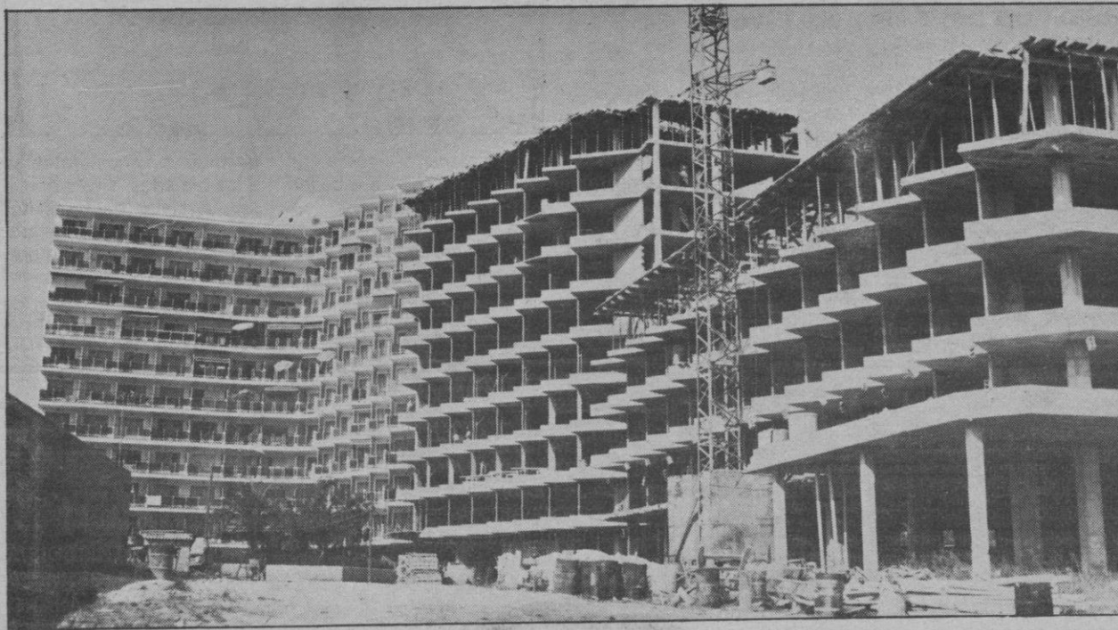
La ampliación del edificio «Apolo XI» es ilegal.
