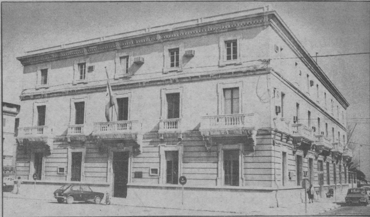
Edificio de la Junta del Puerto donde se están llevando a cabo obras de reestructuración
