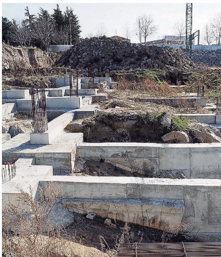
Estado de la obra en el mes de febrero de 2021
