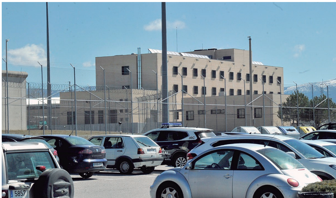
La cárcel de Segovia cuenta con problemas estructurales de personal, según asegura CSIF.
