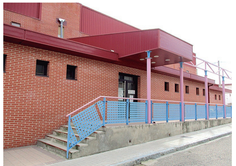
Estado actual de la instalación, tras la reforma.
