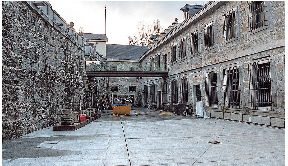
El achique del agua y el buen tiempo permiten ya ver los daños causados en algunas zonas de la ceca. KAMARERO
