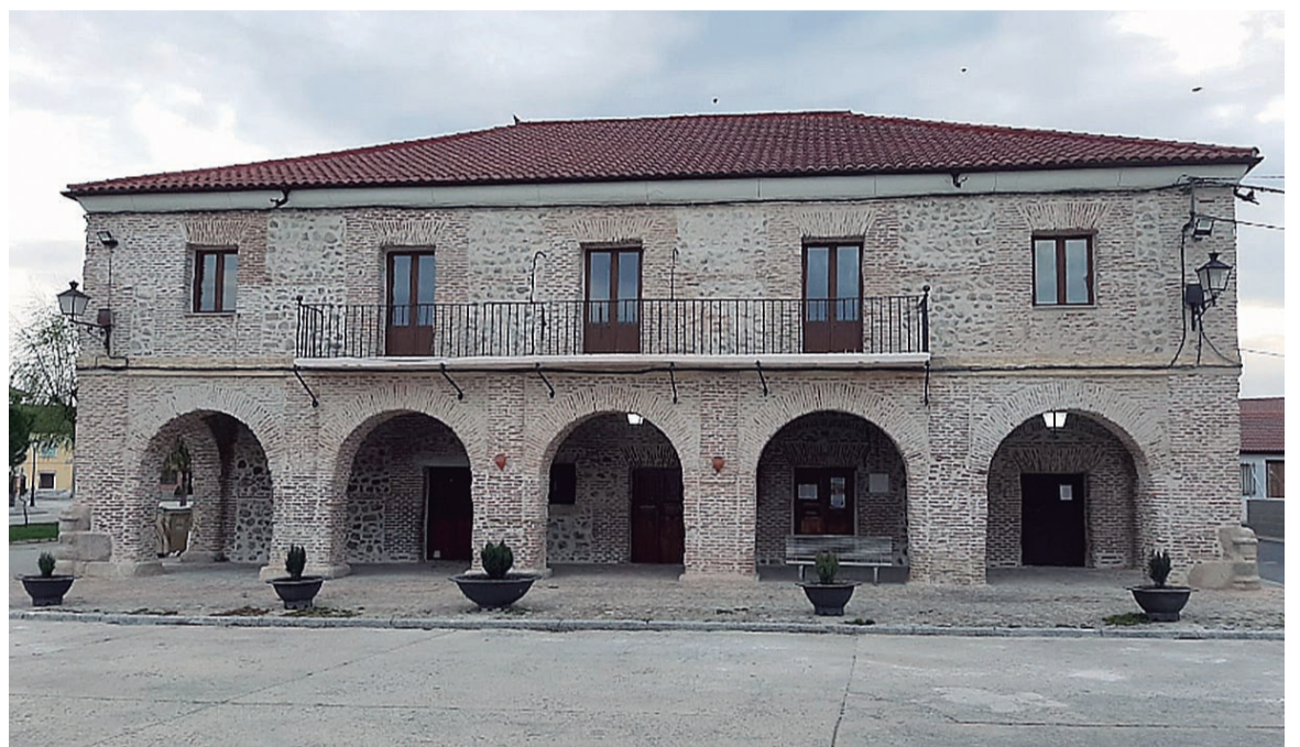
En Labajos se quiere dar a conocer el patrimonio cultural de la localidad, como su Consistorio. E.A.
