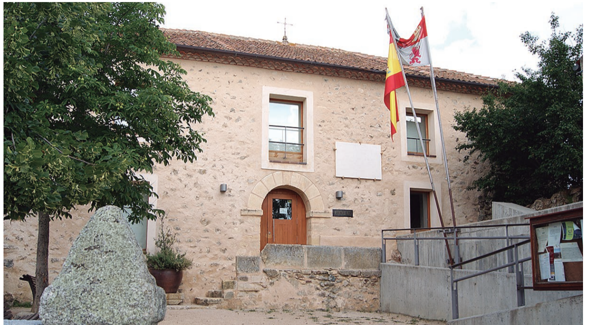
Fachada principal del edificio Consistorial, que en su día fue cuartel de la Guardia Civil.
