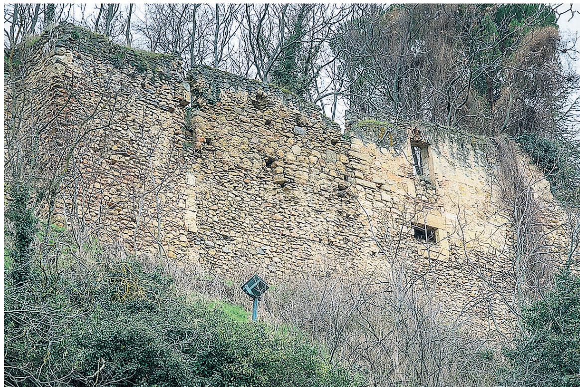
Uno de los tramos de la Muralla de Segovia en peor estado, debido en parte a la vegetación.
