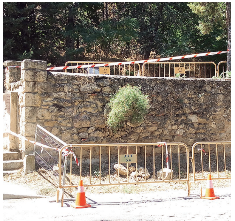
Los trabajos consolidarán el acceso a la zona recreativa.
