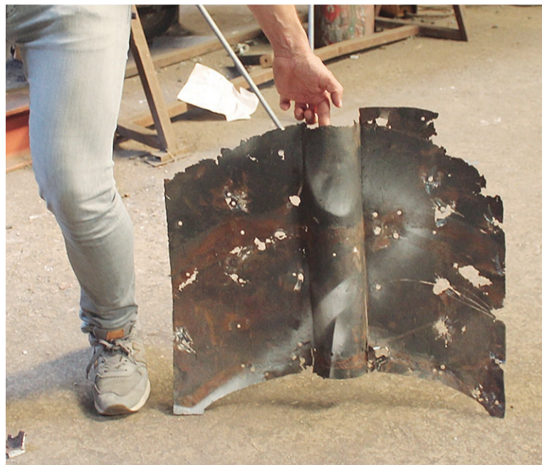
El mal estado de las piezas ha obligado a reemplazar muchas de ellas.
