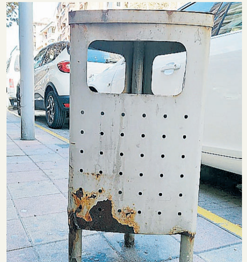
La calle de José Zorrilla es la única que tiene este tipo de papeleras y ya están deterioradas.
