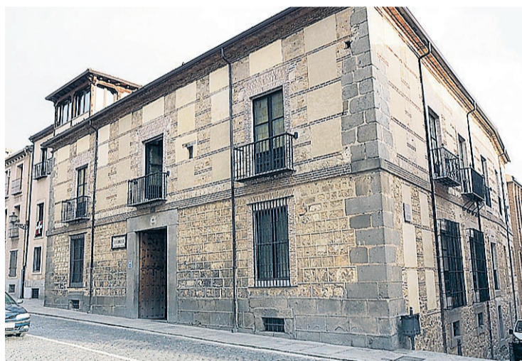
Fachada del Palacio de la Floresta, edificio del siglo XVII.
