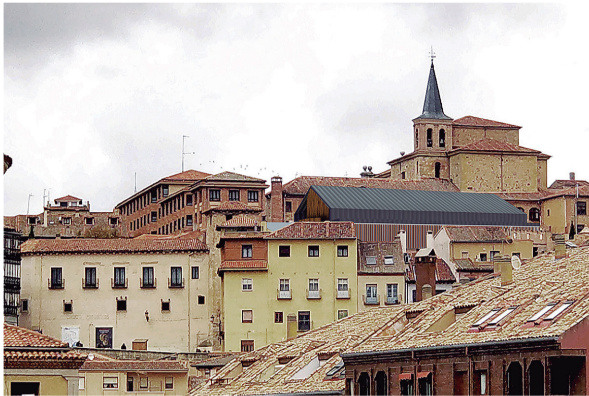
Montaje que muestra la altura que alcanzará la cubierta, la misma que tenía el teatro original.
