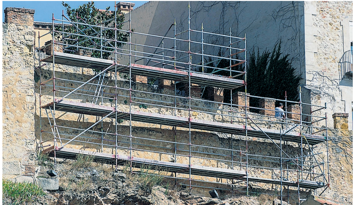
La instalación de los andamios estaba prácticamente finalizada ayer al mediodía.
