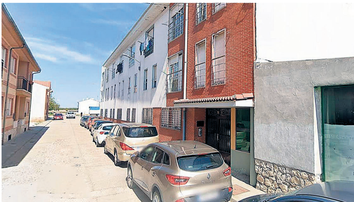
La vivienda se ubica en la calle Uruguay, 36.
