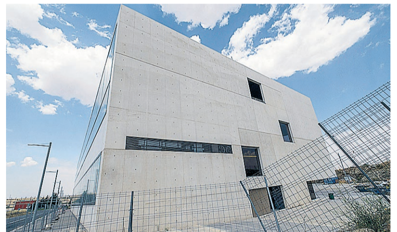
Exterior del edificio CIDE esta misma semana.
